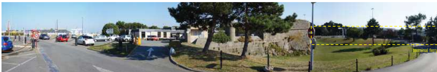
Entité 6 « du terminal ferry à la gare de la Bourse » vue depuis la voie d'accès
